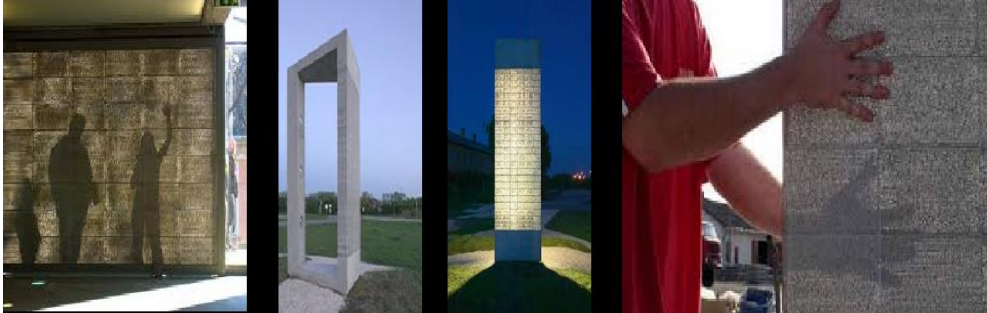
صورة (11) توضح شكل الخرسانة المضيئة (21)
