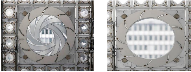
صور (15) وحدة المشربية في الواجهة ومراحلها المختلفة اثناء الفتح والاعلاق حسب الضوء (27)
